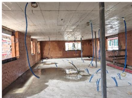
Décoffrage dalle sur étage (Bât. D)
